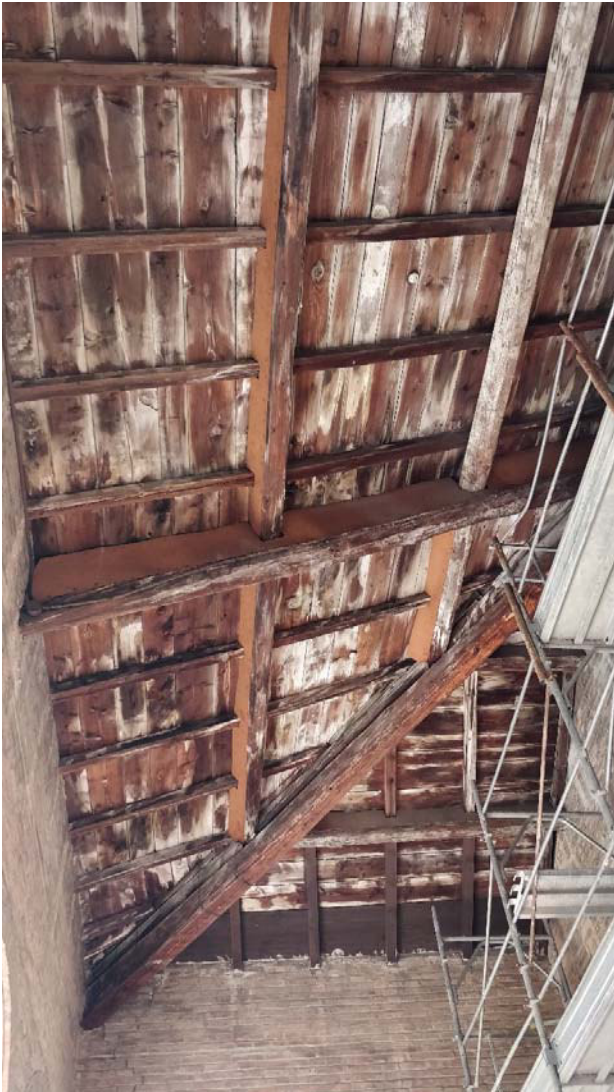
Attuale conformazione della copertura spingente
