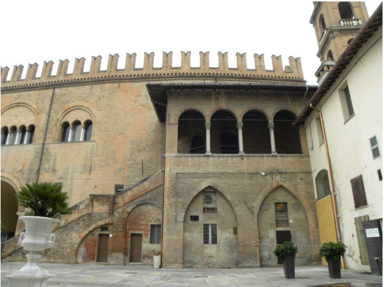
Vista attuale della loggia
